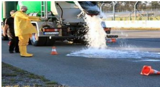
Verhardingen in drainerend beton kunnen de hevigste regenbuien opnemen
