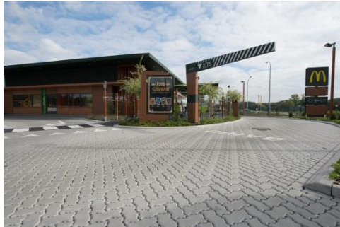
Bestrating in betonstraatstenen met verbrede voegen
