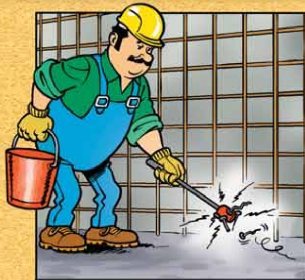
MAAK DE BEKISTING SCHOON MET EEN MAGNEETSTOK EN WATER.
