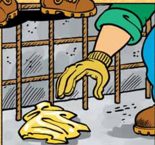
VERWIJDER ZWERFVUIL UIT DE BEKISTING.
