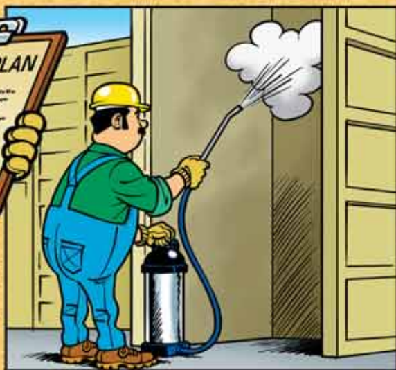
BRENG DE BEKISTINGSOLIE DUN EN GELIJKMATIG AAN.
